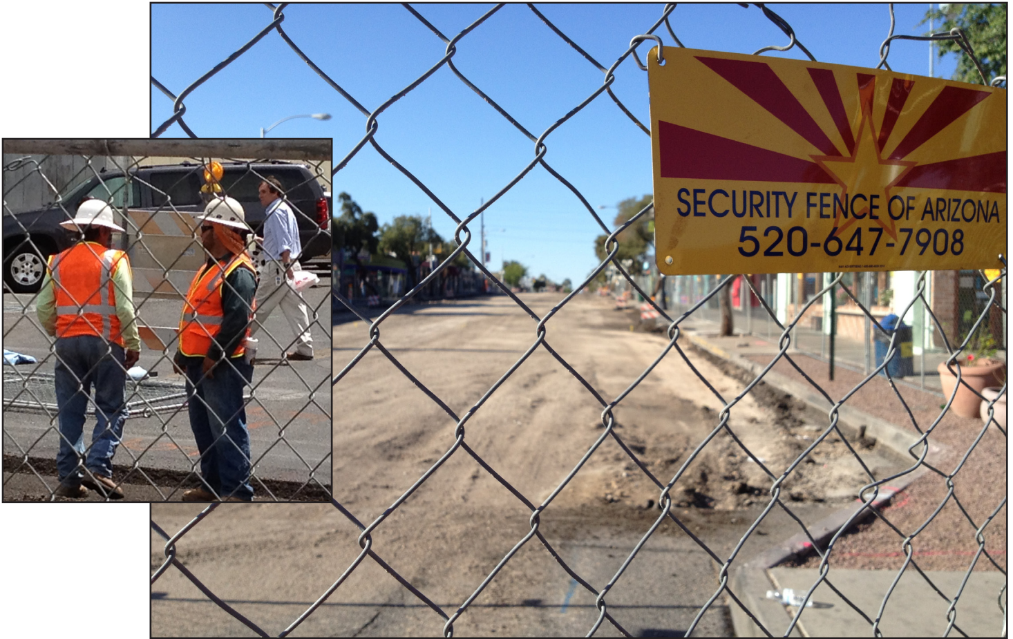
Construction for the Modern Streetcar, now called Sun Link, is underway. Part of Fourth Avenue's main strip is fenced off due to construction on April 16, 2012 in Tucson, Ariz. | La construcción del moderno tranvía, ahora llamado Sun Link , está en curso. Parte de la calle principal de la Fourth Avenue está vallada debido a la construcción del 16 de abril en Tucson, Arizona.
